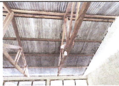
FOTO 6: Sustrucción de focos ahorradores
