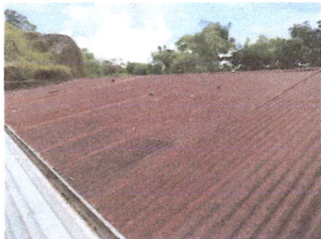
FOTO 1: Sustrucción de lámina, por lámina troquelada o acanalada aluzinc calibre 26
